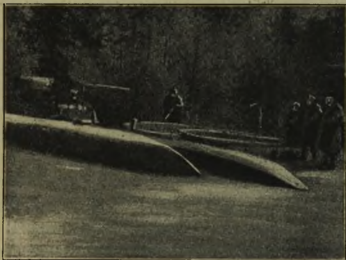
Рис. 9.—Постройка обласовъ (челновъ) на р. Вахѣ.
